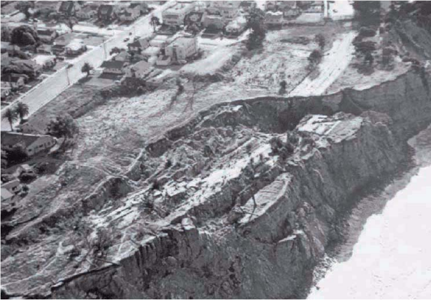
Dik yar oluşturan kıyılarda kıyı aşındırılması oldukça yaygındır. Aşınma özellikle kıyıyı oluşturan birimlerin dayanımına sıkıca bağlıdır. Özellikle dayanımsız kayalarda aşınma yoğundur.
